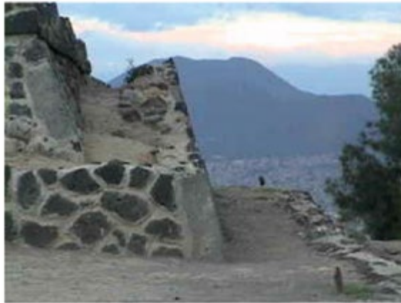
Talud Sur de la Estructura I, Etapa Mexica TFN-V (1507 dC).
